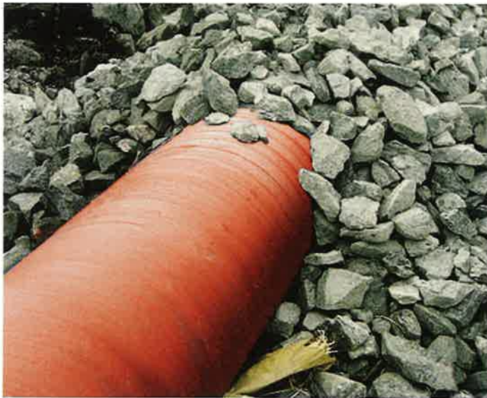
5 Links: Einbau von duktilen Gussrohren in einem Boden mit gebrochenen grobkörnigen Steinen.
