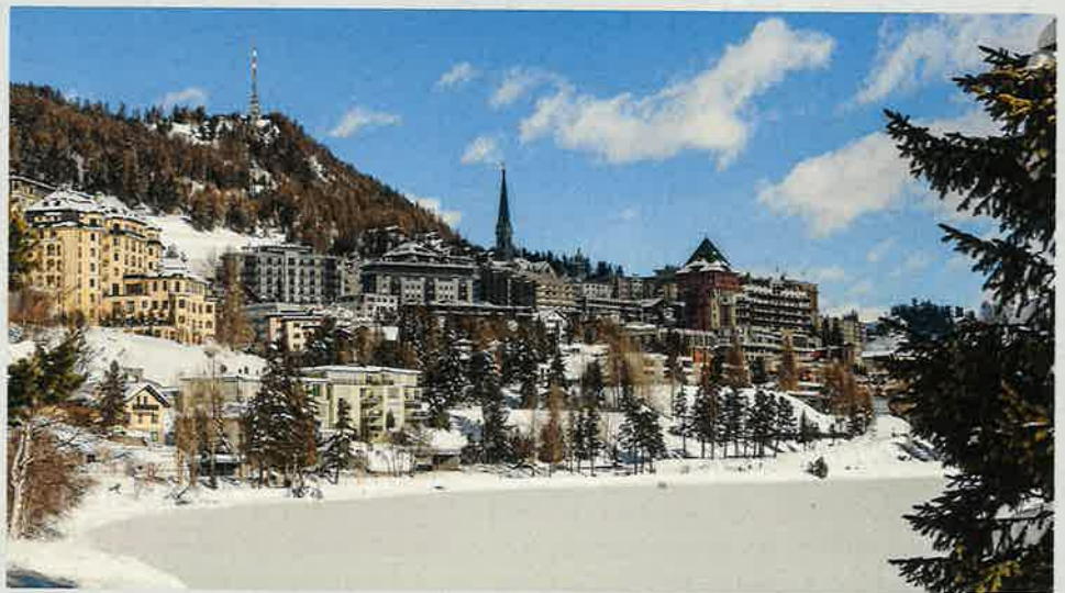
Fig. 5 Seewassernutzung für Wärme und Kälte funktioniert auch auf 1750 m ü. M. – selbst im Winter bei zugefrorenem See.
